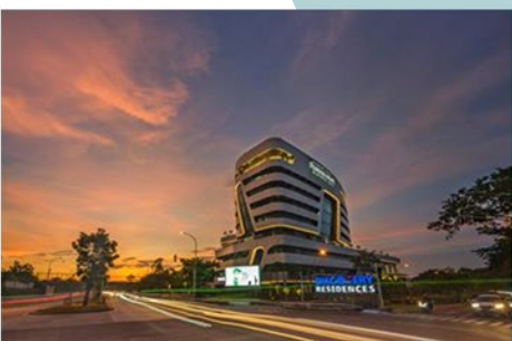
RS. Pondok Indah Bintaro
